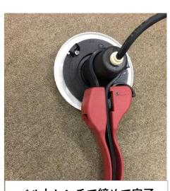
ベルトレンチで締めて完了
