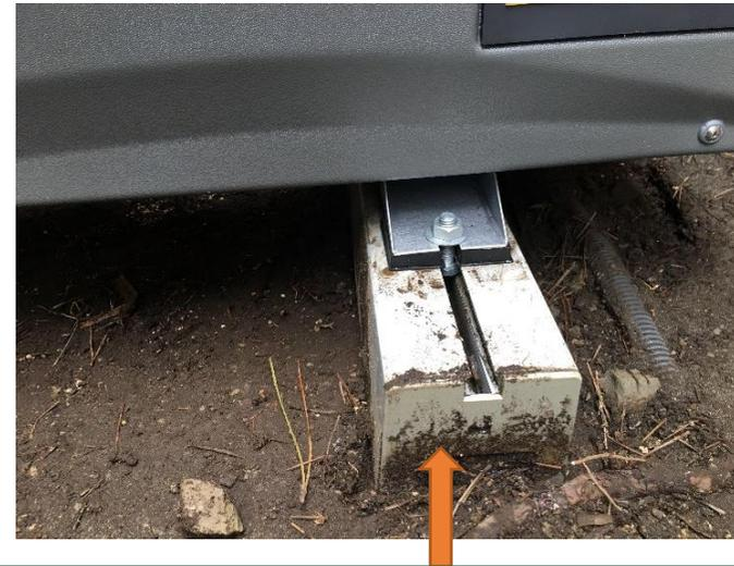
・プール用ヒートポンプは固く安定した水平面に置いてください。(コンクリート基礎の上が理想的です。)
