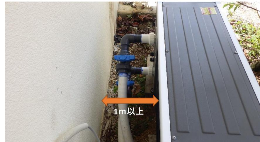
・背面、側面(エバポレーターの吸込み口)は1m以内、正面(吹き出し口)は3m以内には何も置かないでください。
